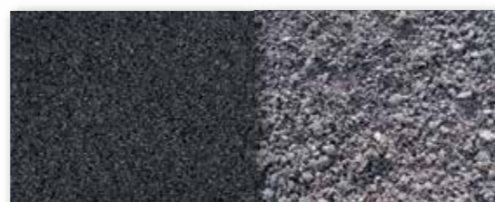
BITUME ET GRAVIER D'ASPHALTE APRÈS
