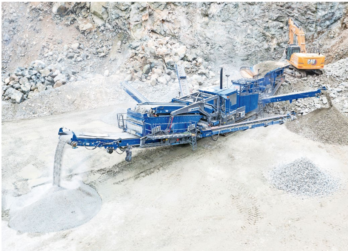
Oben links: Die erste mobile Brechanlage von Gipo. Oben rechts: Weltgrösste raupenmobile Brechanlage von Gipo. Grosses Bild: Raupenmobile Prallbrechanlage Giporec R 130 im Einsatz.
